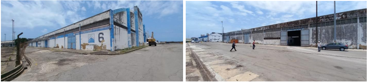
Figura 2 – Vista externa do Armazém 06.
