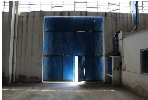
Figura 11 – Portão de acesso de máquinas, veículos e pessoas ao Armazém 06, com o escritório ao lado.
