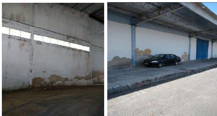
Figura 9 – Parede interna e externa do Armazém 06. Fonte: Porto do Recife S/A.
