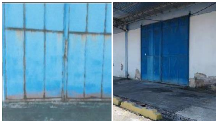
Figura 5 – Portões da fachada oeste do Armazém 06.
