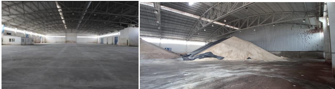
Figura 4 – Área de armazenagem do Armazém 06.
