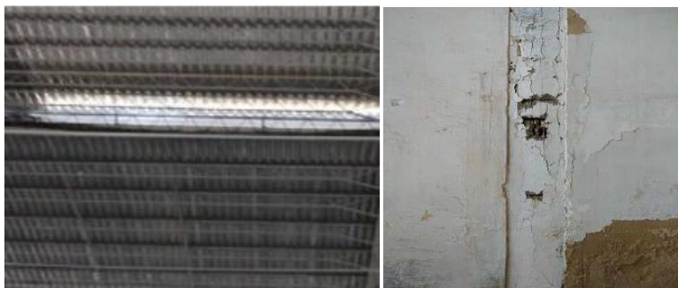
Figura 8 – Coberta e estrutura, interna ao Armazém 06. Fonte: Porto do Recife S/A.
