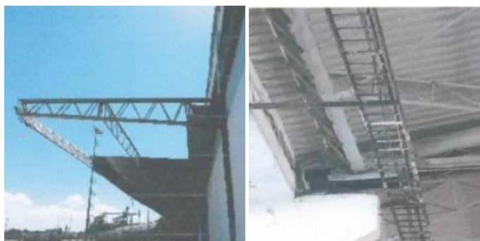
Figura 7 – Alpendre e eletrocalha, externos ao Armazém 06. Fonte: Porto do Recife S/A.
